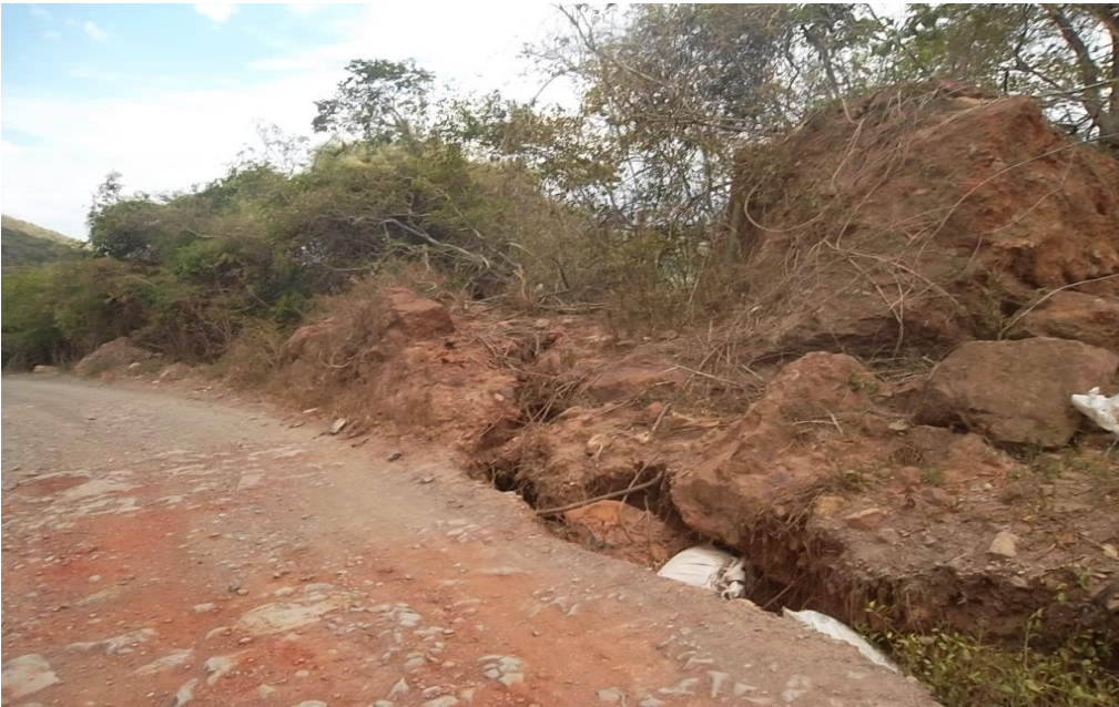
DILATACION EN EL TALUD DE LA VIA
